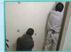
⑤仕上げ(塗膜の磨き、 端部コーキング処理)
