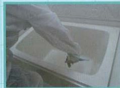
③塗料の吹付け
