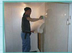
④シート・パネル貼り
