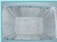
②下地補強(ガラスクロス ライニング・当て板補強)
